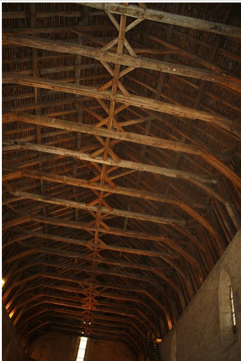
La charpente de l'église du couvent des Cordeliers
